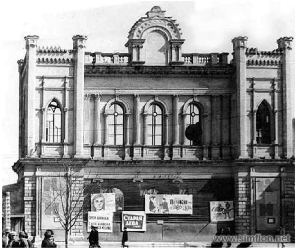
Рис. 44. Здание Хоральной синагоги г. Симферополя, 1881 г. Фото 1972 г., во время функционирования ее в качестве кинотеатра.
