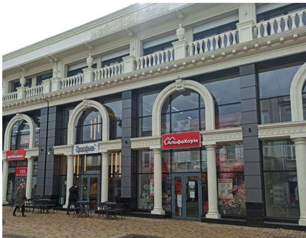
Рис. 21. Современное здание, 2019 г., г. Симферополь, ул. Екатерининская.
